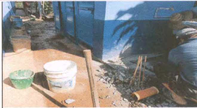
Foto 20: Sustitución de tubería de PVC línea principal de aguas negras del Módulo Sanitarios.
