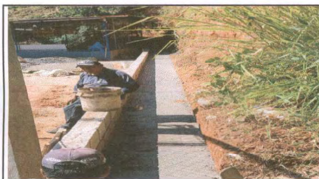
Foto 15: Reparación de cuneta de concreto ancho de 0.60 del Módulo Patio.
