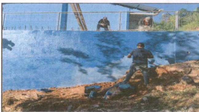
Foto 16: Pintura en muros exteriores del Módulo Patio.
