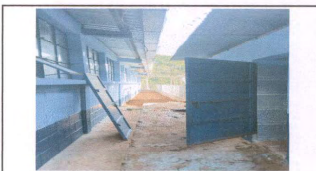
Foto 18: Mantenimiento a estructura (Lijado, Cambio de tubo, Cepillado, Sujeciones, Aplicación de Pintura) a puertas de Servicios Sanitarios.
