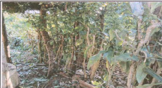
Foto 25: Reparación de cerco con alambre de puas en el área perimetral del Centro Educativo.
