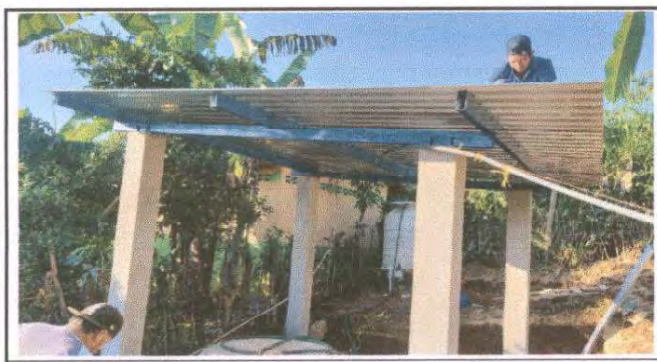
Foto 23: Sustitución de lámina, por lámina troquelada aluzinc calibre 26. Sustitución de estructura de soporte de madera, por metal del área superior del Centro Educativo.
