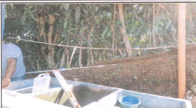
Foto 19: Sustitución de llave de paso por llave PVC de 1" del Módulo Sanitarios.
