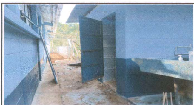
Foto 17: Pintura en muros exteriores e interiores del Módulo Sanitarios.
