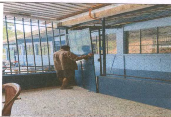
Foto 4: Fabricación e instalación de puertas de metal en Módulo Aulas.
