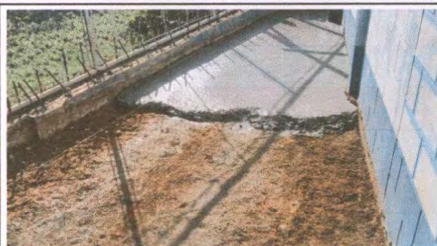
Foto 8: Reparación de banquetas de concreto en la parte de atrás del Módulo Aulas.
