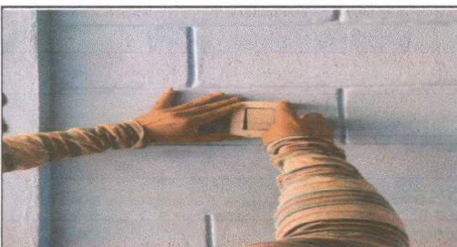
Foto 11: Sustitución de interruptores dobles por interruptor triple de Módulo Aulas.
