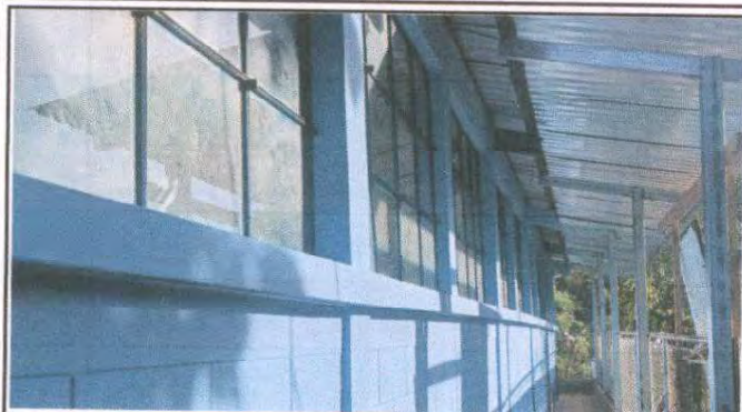
Foto 1: Sustrucción de lámina, por lámina broquelada aluzinc calibre 26 del Módulo Aulas.
