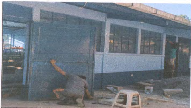
Foto 3: Mantenimiento a estructura (fijado, cambio de tubo, cepillado, sujeciones, aplicación de pintura) de las puertas de metal del Módulo Aulas.
