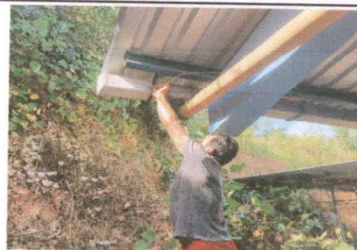
Foto 6: Sustrucción de canal de PVC del agua pluvial del Módulo Aulas.
