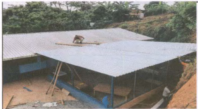
Foto 22: Sustitución de lámina, por lámina troquelada aluzinc calibre 26 del Módulo Cocina.
