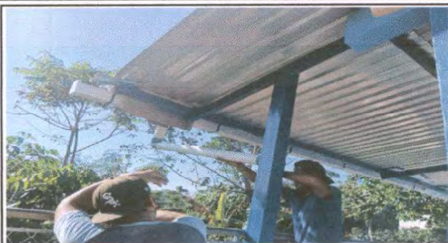
Foto 7: Sustitución de bajada de agua pluvial, tubo PVC 3" de Módulo Aulas.
