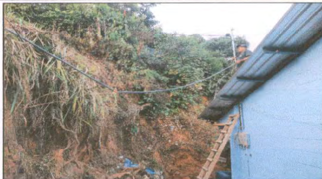
Foto 13: Reparación de cableado eléctrico y sustitución de ducto eléctrico más accesorios en el Centro Educativo.
