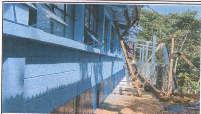
Foto 2: Sustrucción de estructura de soporte de madera, por metal en la estructura de Módulo Aulas.
