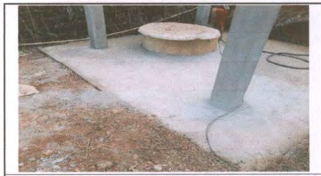
Foto 24: Sustitución de piso de torta de concreto en el área superior del Centro Educativo.
